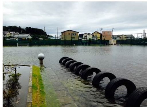
写真 2-6 雨水貯留浸透施設
