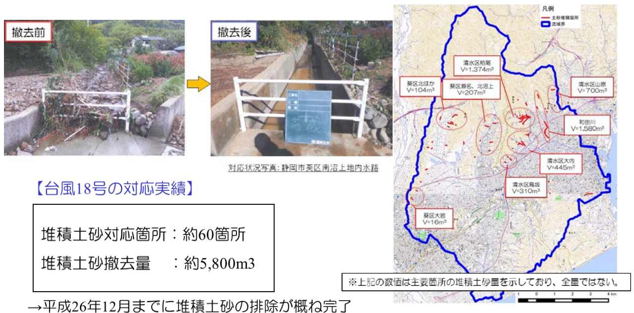
図 4-8 静岡市による土砂浚渫実施状況
