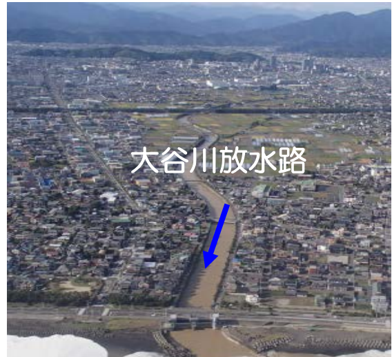
写真 2-3 大谷川放水路(平成 11 年完成)
