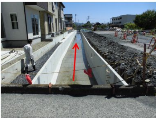
写真 2-5 雨水きよ整備
